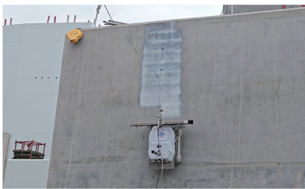
▲负压吸附式混凝土喷涂机器人在喷涂底漆。
