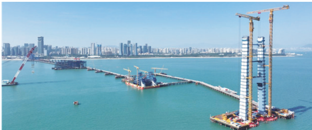
▲正在建设中的厦金大桥厦门段。(中交二航局/图)
