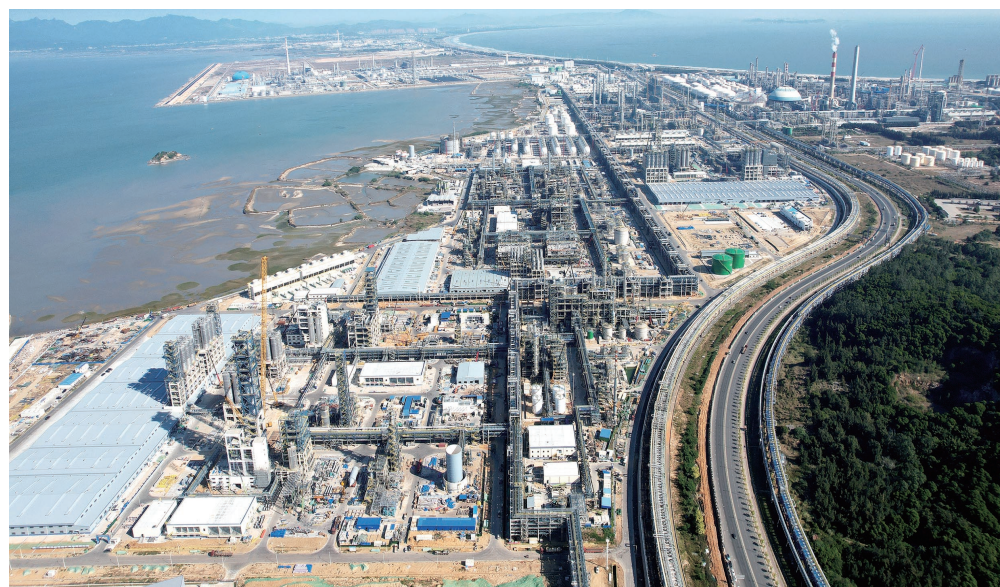
▲中沙古雷乙烯项目部分航拍图。詹照宇/摄
