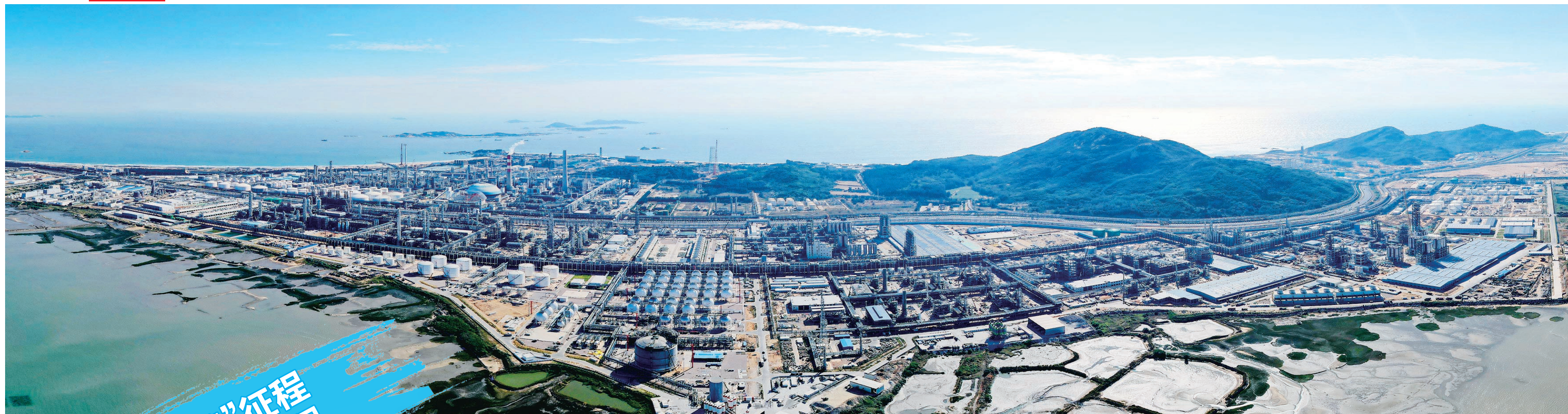
▲中沙古雷乙烯项目部分航拍图。詹照宇摄
