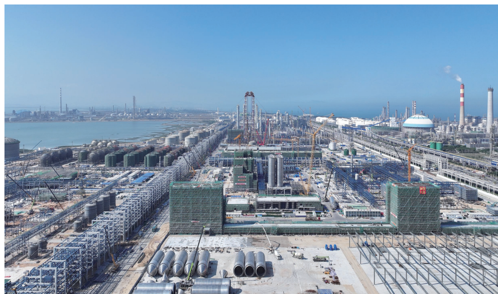
▲中沙古雷乙烯项目建设现场。柯少如/摄
