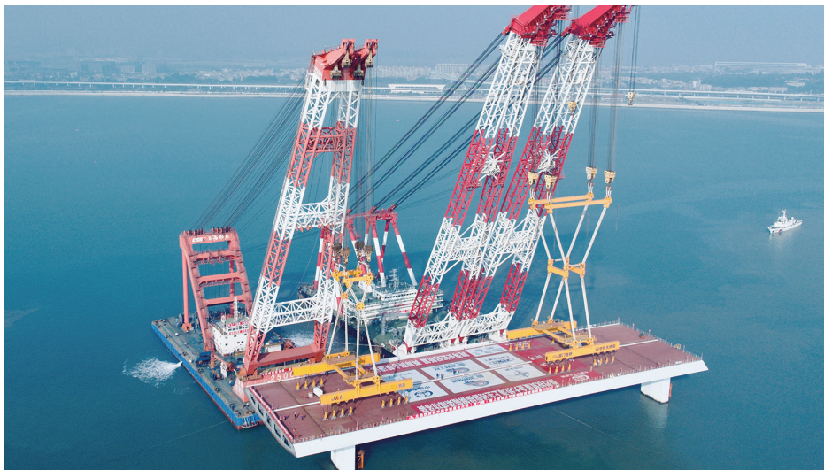
▲20日,厦金大桥厦门段海上首榀钢箱梁吊装成功。
