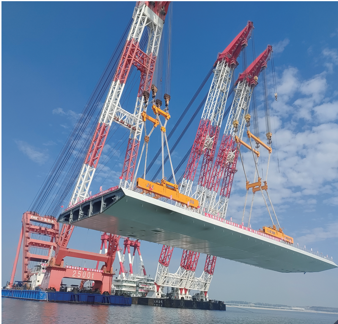
▲12月20日下午,厦金大桥厦门段项目迎来重大建设节点,海上首榀钢箱梁吊装成功。
