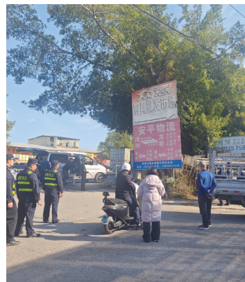
▲拆除违规广告牌。
