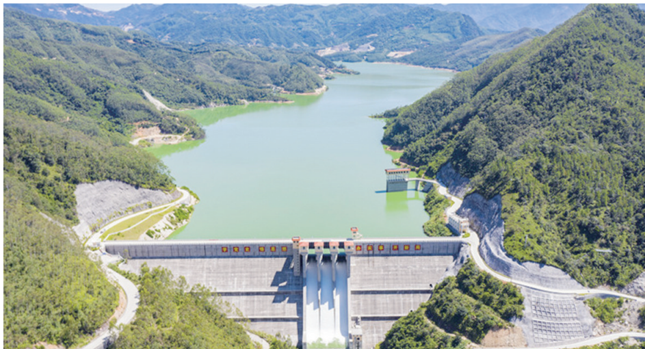
长泰枋洋水利枢纽工程航拍图。
