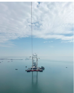
▲厦金大桥(厦门段)刘五店航道桥先导索顺利完成跨岸连接。
