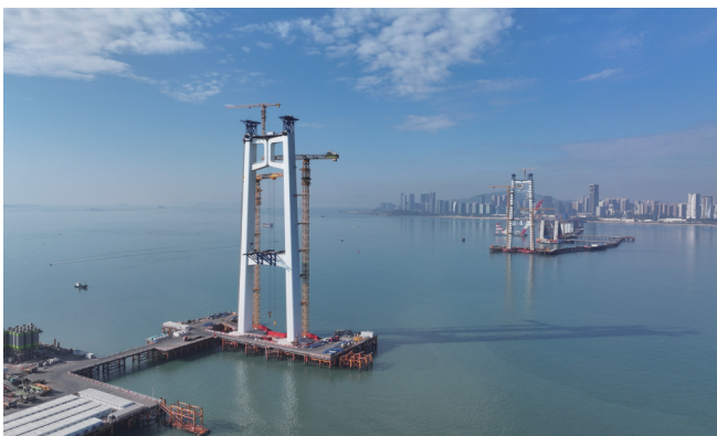
▲厦金大桥(厦门段)刘五店航道桥先导索顺利完成跨岸连接。
