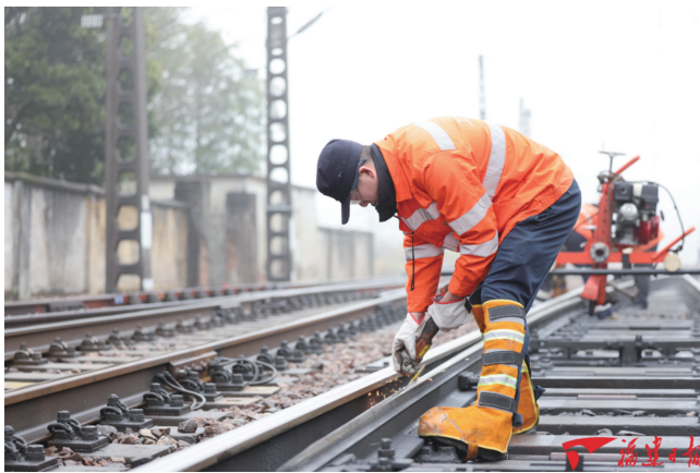
▲作业人员手工打磨道岔尖轨。
