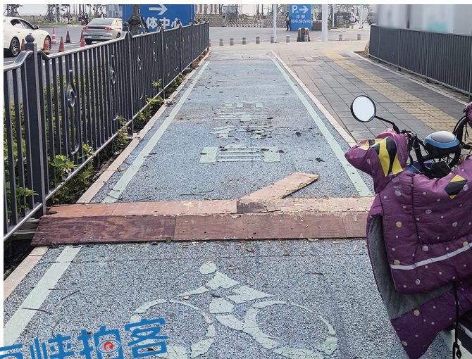
▲一道10厘米高的坎横在非机动车道上,给过往车辆带来安全隐患。
