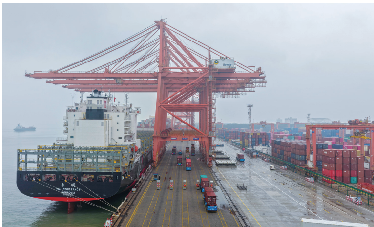
▲新航线“永明”轮靠泊厦门港海润码头。
