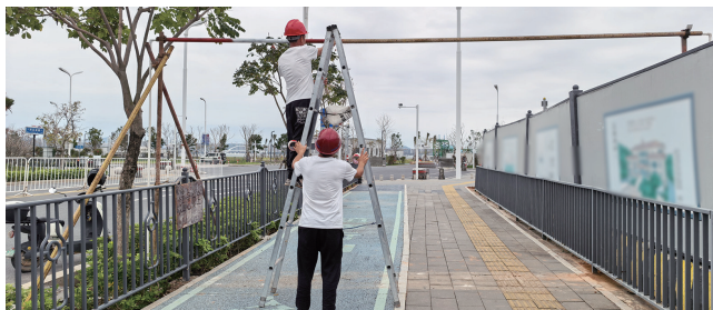
▲木坎拆除了,管道搬到空中,工作人员给钢管喷涂警示漆。
