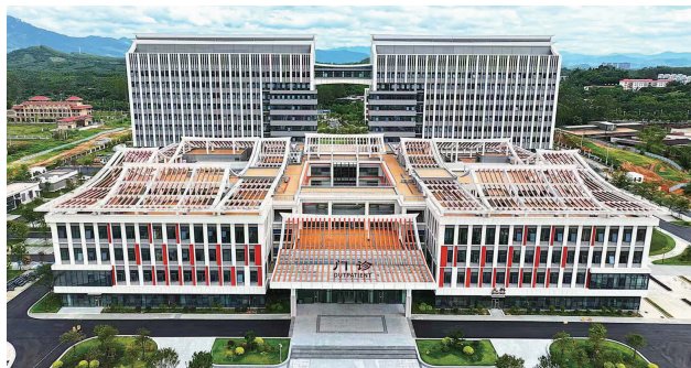
▲长泰区医院新建工程。
