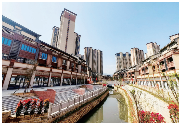
下港片区棚户区改造建设项目(02地块)。
