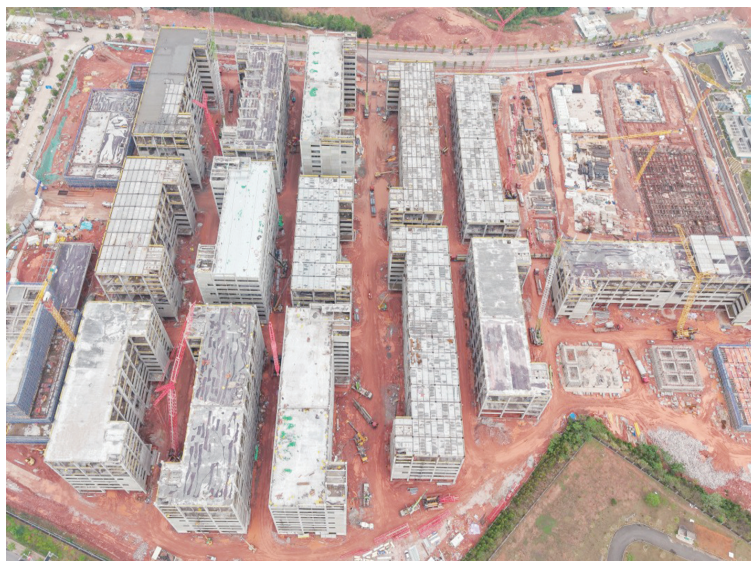
上杭环保科技有限公司产业园一期项目。
