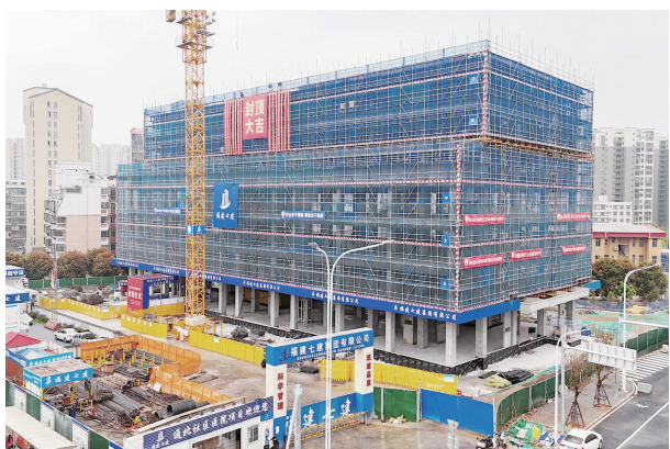
芗城区公共卫生防控能力建设工程(通北社区医院)。
