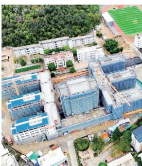
漳州一中古雷港分校扩建项目二期工程。
