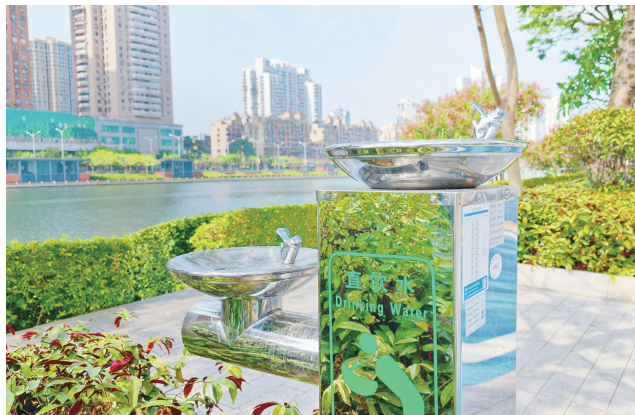
滤过滤系统,水质洁净,可直接饮用,管理人员也会对设备进行常态化巡查,定期更换滤芯,让市民喝得更加放心。
