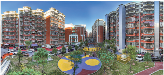
▲改造后的鑫荣小区西区
